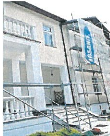
W Brniu trwają prace renowacyjne
